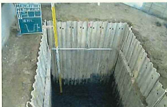
工事写真2 床付けの完了状況
