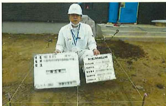
工事写真1 着工前
