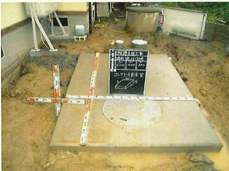
工事写真13 上部スラブコンクリート状況
