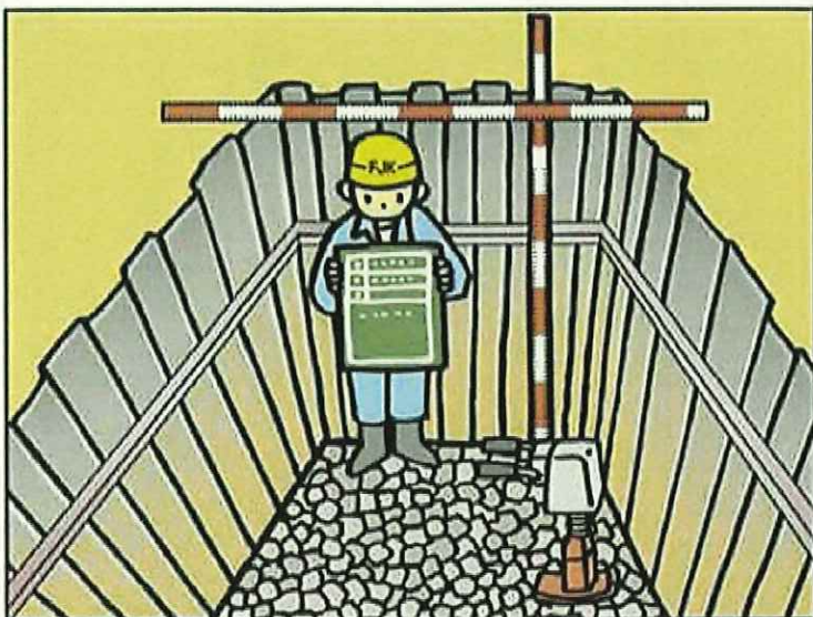
工事写真4 基礎砕石敷設転圧工事状況 (イラスト2)
