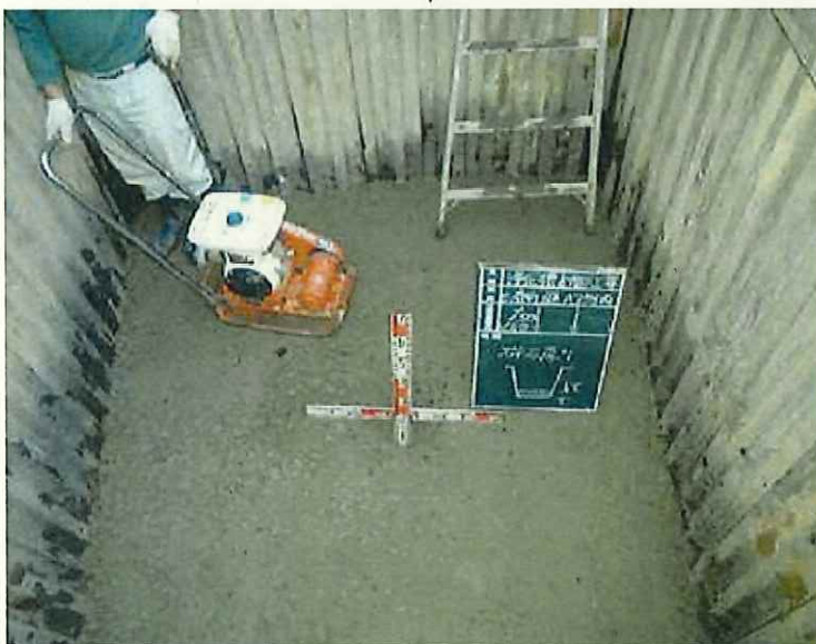
工事写真5 基礎砕石敷設転圧工事状況 (参考)
