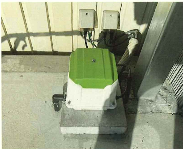
工事写真14 ブロワ設置工事
