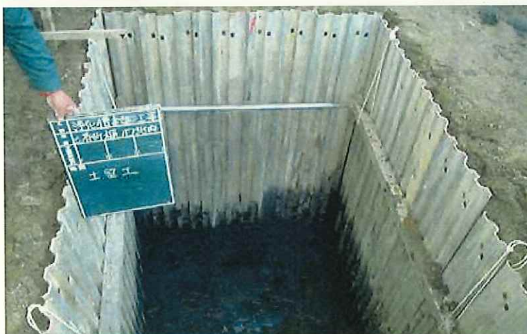
工事写真3 山留め工事状況
