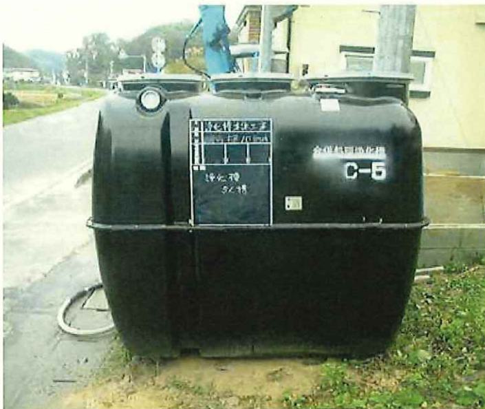
工事写真8 浄化槽本体搬入
